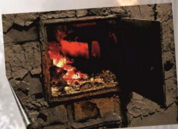
Эксплуатация неисправных печей
